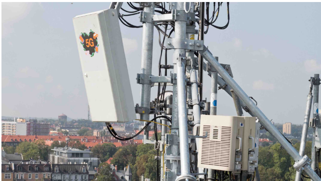
Antenne et station 5G déployée à Lyon (Orange)
